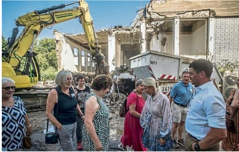
Baubeginn am ehemaligen Haus der Deutschen Bank in der Birkenbergstraße: Bauherr ist der Bauverein Opladen. Mitglieder des Vereins „Solemio“ wollen hinterher dort leben. (Foto: Ralf Krieger)
